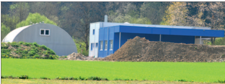
Ein imposanter Bau ist die neue Werkstatt geworden.
